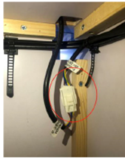
步骤五：装好后插上 对接线
