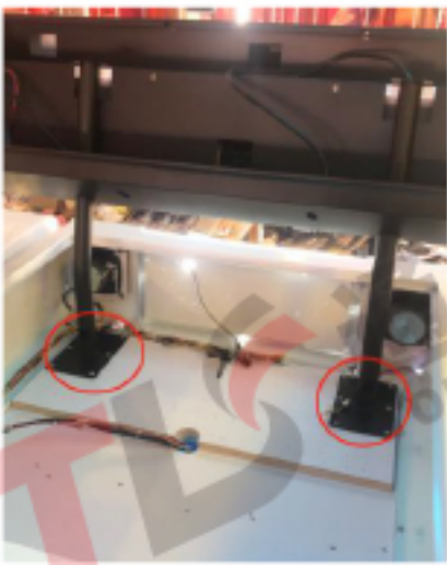
步骤二：扶好灯箱， 对准螺丝孔
