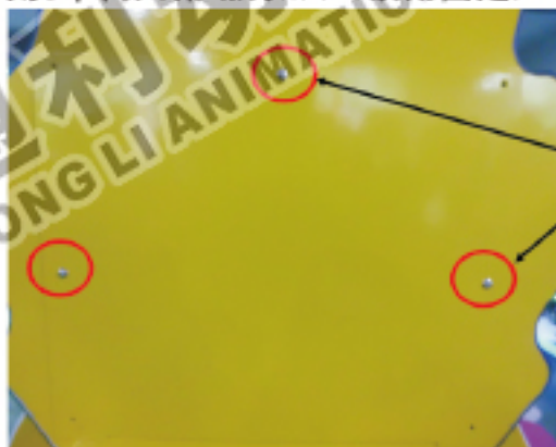
第四步：将灯箱维修门放置定位后，用3个内六角螺钉M4*8锁附固定。
